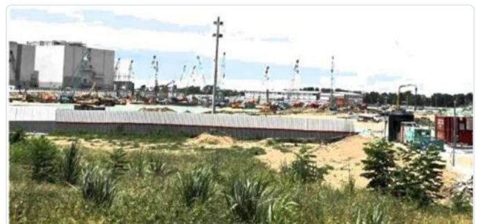
AP7 P3/4：尚未動工（吊車整地中）
